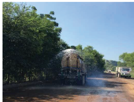
รูปที่ 2-10: การฉีดพรมน้ำบนเส้นทางลำเลียงแร่ ภายในโครงการ
